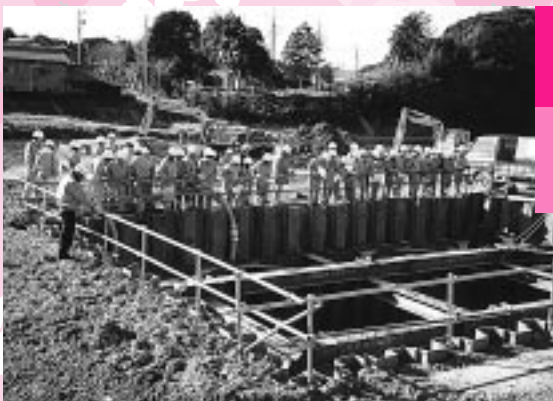
2月9日に実施した磐田農業高等学校一年生の工事現場見学会 農道整備(広域)北小笠地区(橋梁下部工事)現場(掛川市吉岡地内)にて
