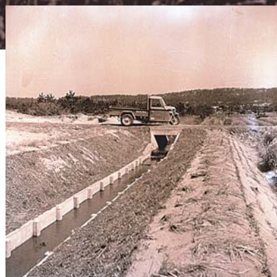
農地排水路完成写真
