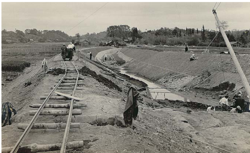
↑ 東山沢川改修工事
