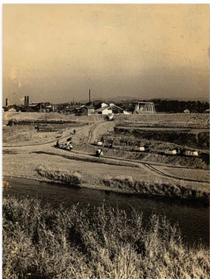
↑ トロッコを使用している土砂の運搬
