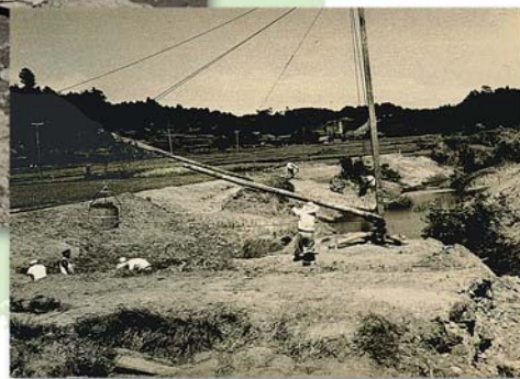
↑ 掘った土を移動させるために使われた、ドラム缶を利用したデリック
