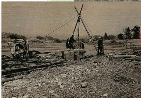
↑ 重たい物を吊り上げるにはチェンブロックを使用
