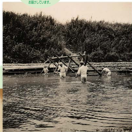
↑ 伝統的治水工法の一つ、「牛」といわれる水制
