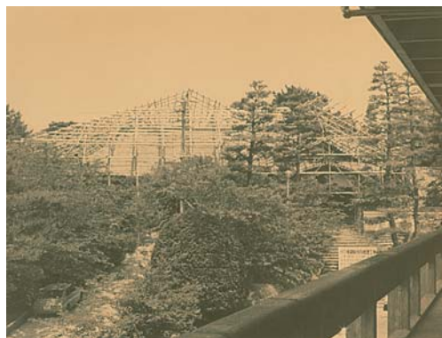
↑ 掛川城御殿 修復工事
