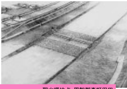
太田川取水堰 (計画図) 取水堰地点:周智郡森町円田 形式:ラバーダム 用途:上水
